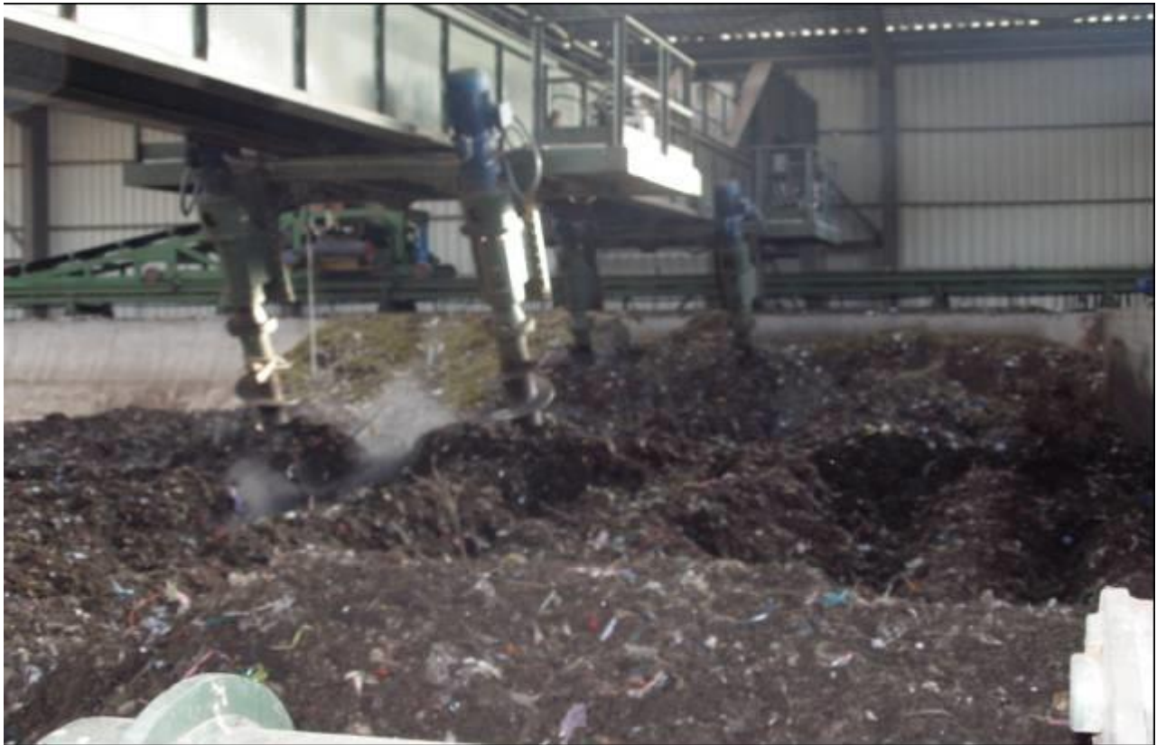
Εικόνα 5: Δεξαμενή Κομποστοποίησης (ΔΕΔΙΣΑ)
